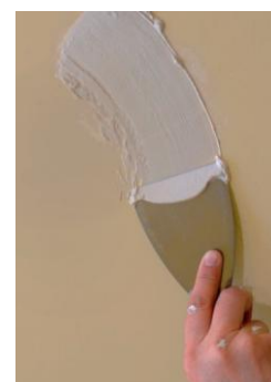
5. Enmasillado de las perforaciones
