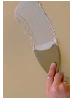
5. Enmasillado de las perforaciones
