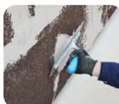
Aplicación de acabado final de la placa
