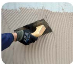
Colocación de las placas
