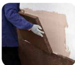
Fijación de las placas
