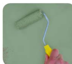
Aplicación de acabado final de la placa
