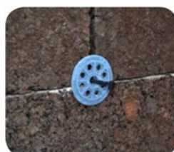
Fijación de las placas
