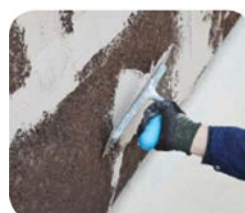
Aplicación de masilla térmica
