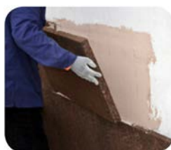
Colocación de las placas
