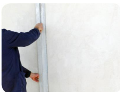
Regularización de la superficie
